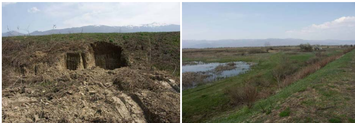
Фигура 126 - Уништување на насипот на еден поранешен рибник. Фигура 127 - Сегашна состојба на еден поранешен рибник.
